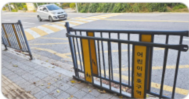
어린이보호구역 안전시설 파손
